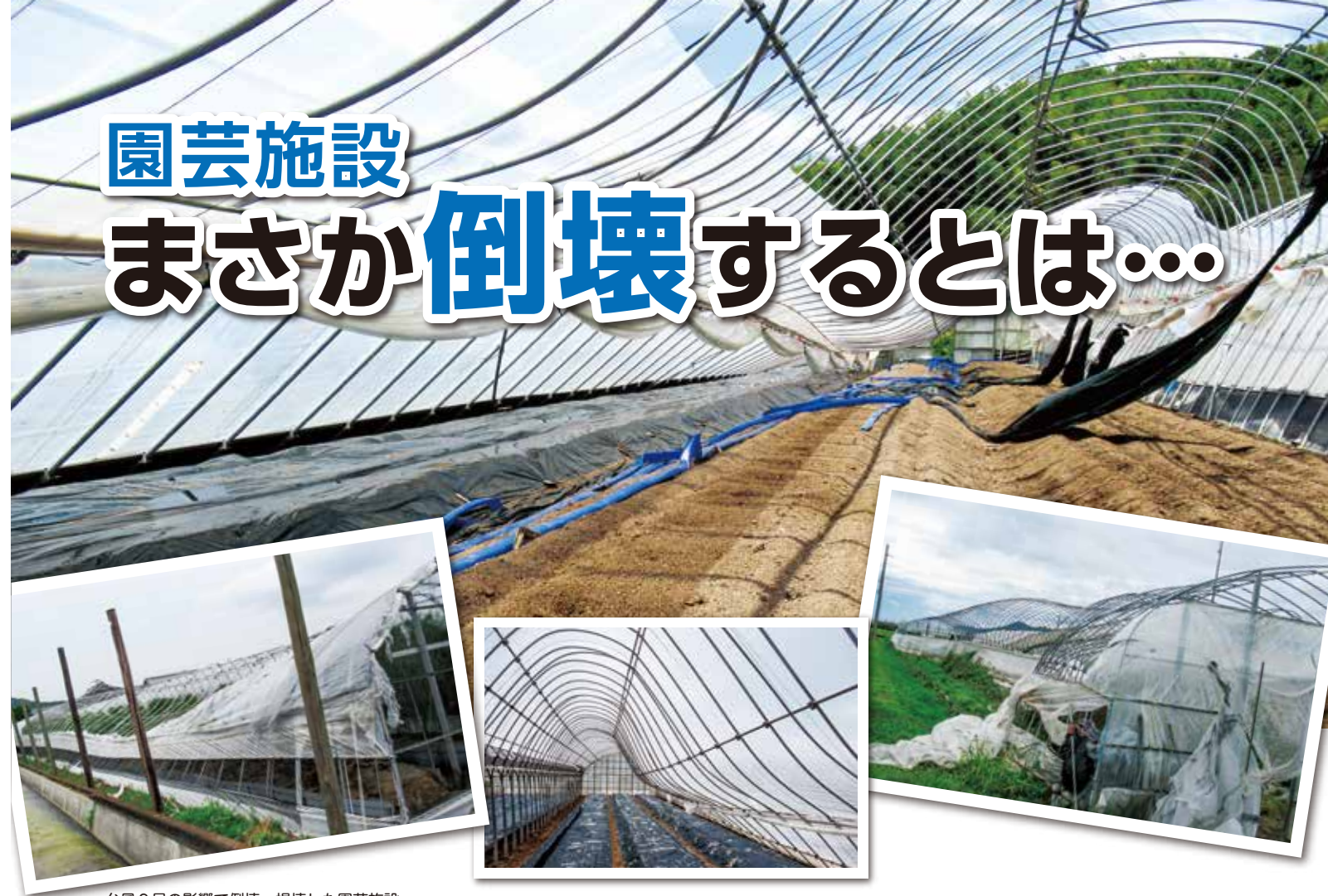
台風9号の影響で倒壊・損壊した園芸施設
