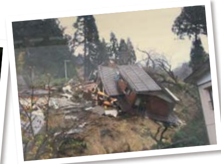
土砂崩れで倒壊した住宅
