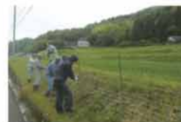
高さ1.2m、幅2mのワイヤメッシュを3000枚使用して農地を囲む
