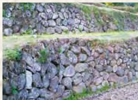
斜面に積み上げられた石積み
