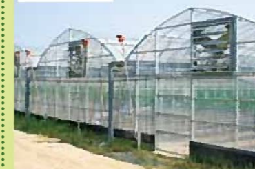
ガラス室、プラスチックハウス、 附帯施設、施設内農作物
