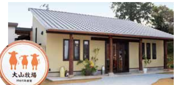
令和3年8月にリニューアルオープンした店舗
