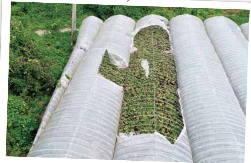
被覆材が一部のみ破れた連棟のハウス
