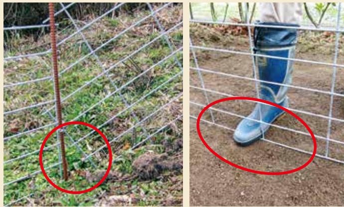
パネルの継ぎ目に隙間ができないようにしましょう 地際部はしっかりと踏み込みましょう
