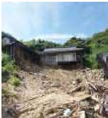
地盤が崩れ、手前にあった住宅が倒壊。写真は残った一部の住宅(三豊市詫間町)
