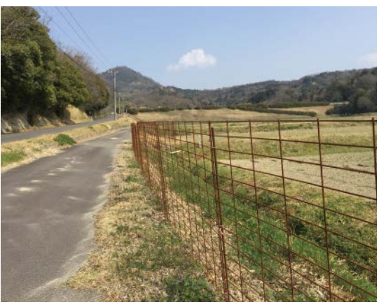
ワイヤーメッシュ柵施工事例
